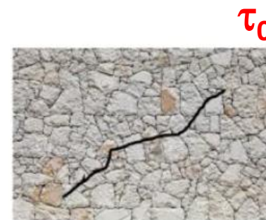
Muratura irregolare Fessurazione diagonale
