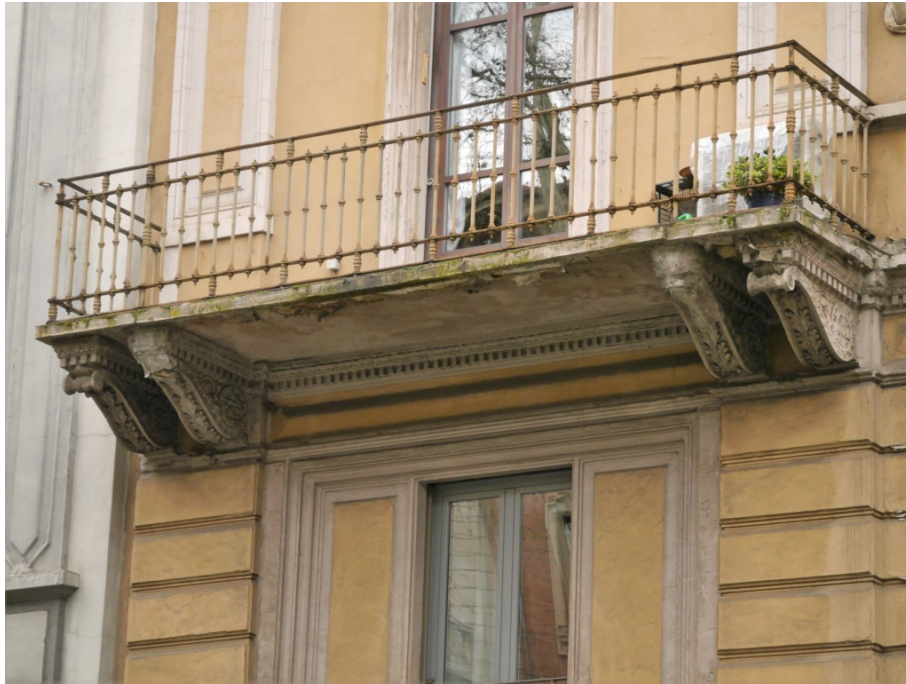
Vista di dettaglio delle mensole reggi balcone del secondo piano
