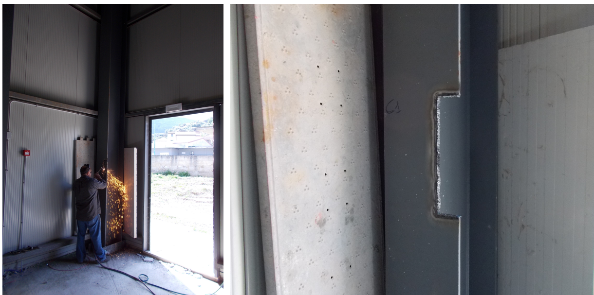
Figura 3a-b - Prelievo in opera di un saggio di carpenteria metallica
