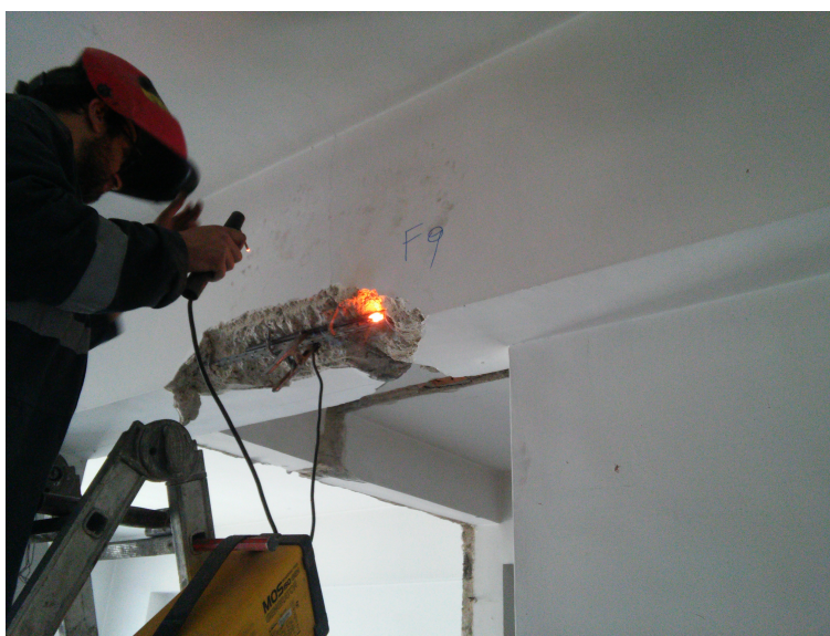
Figura 1 - Ripristino di barre d'armatura mediante saldatura
