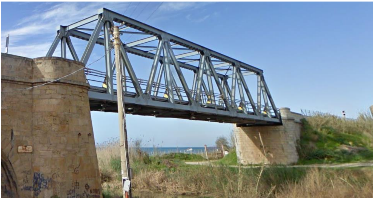
Figura 3 - Vista laterale del Ponte Forgia
