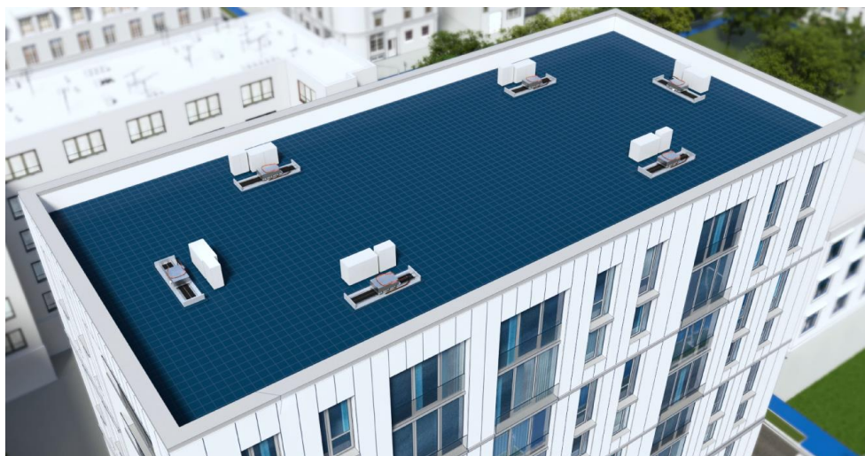
Figura 1 - Concept di un intervento di retrofit antisismico con tecnologia AMD: l'installazione in copertura di un determinato numero di dispositivi consente di aumentare la sicurezza del fabbricato in modo del tutto non invasivo
