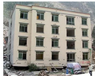
Figura 7 - Foto di crolli in occasione del sisma in Abruzzo 2009 (fonte Reluis 2009)
