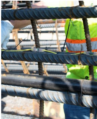
Figura 6 - fissaggio dei cavi lungo la gabbia di armatura
