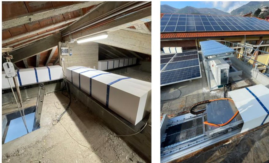
Figura 14 - Immagini dal cantiere: AMD nel sottotetto del corpo A ed in copertura del corpo B
