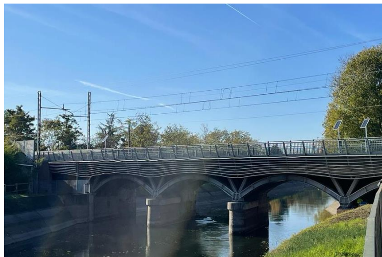
Figura 5 - Foto del ponte in esame su cui è avvenuta l'installazione Tokbo
