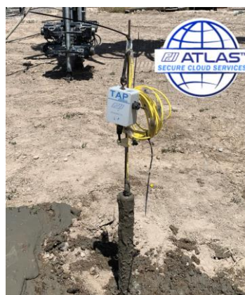
Figura 21 - installazione cavo con sonde di temperatura su micropalo
