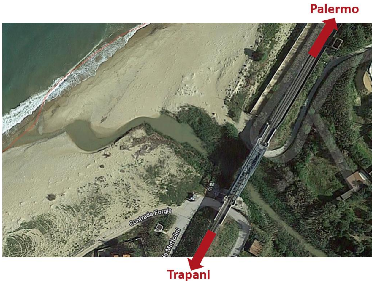
Figura 1 - Ponte Forgia vista dall'alto
