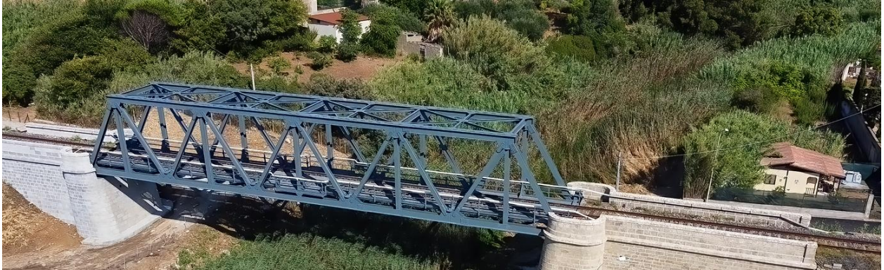
Figura 24 - Foto del ponte Forgia a lavori ultimati
